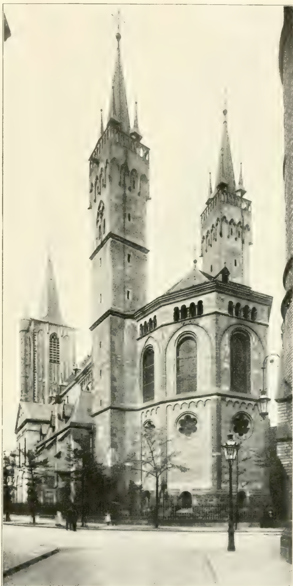
Abside de l'église Saint-Séverin.
